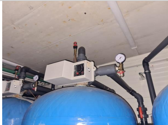
Ūdens apstrādes un attīrīšanas iekārtas EUROTROL
