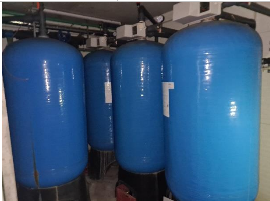
Ūdens apstrādes un attīrīšanas iekārtas EUROTROL
